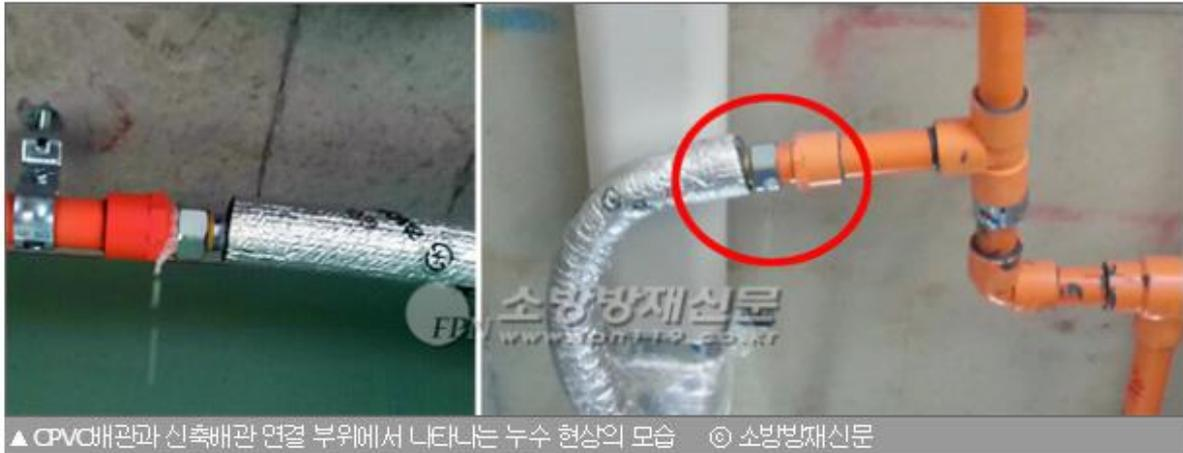
CPVC 소방용 배관을 적용한 건축물의 누수 문제는 CPVC 제조사와 스프링클러 신축배관 업체 간의 심각한 분쟁으로까지 이어지고 있다. 시공사나 발주처는 CPVC배관의 이음관인 밸브소켓과 신축배관 너트의 결합 적합성 문제 등을 이유로 누수 책임을 양 제품 제조사에게 돌리고 있는 양상이다.
